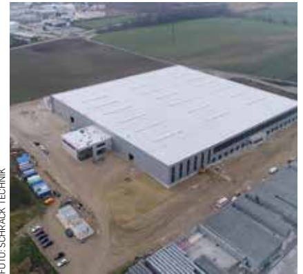
FOTO: SCHRACK TECHNIK
